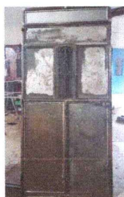
Foto 3: Reparación y mantenimiento en puerta de aulas
