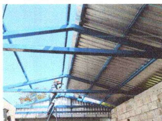
Foto 1: Sustrución de lámina troquelada calibre 26 y sustrución de estructura de techo
