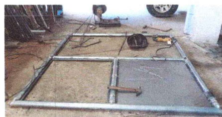
Foto 4: Sustrución de portón con tubo y malla
