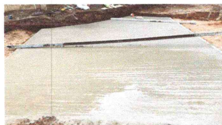
Foto 6: Sustrución Losa de Patio
