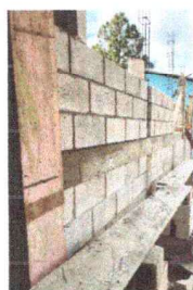
Foto 5: Sustrución de muro perimetral
