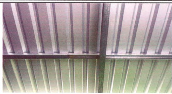
Foto 2: Estructura de techo
