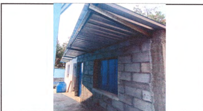
Foto 6: Reparación área de cocina
