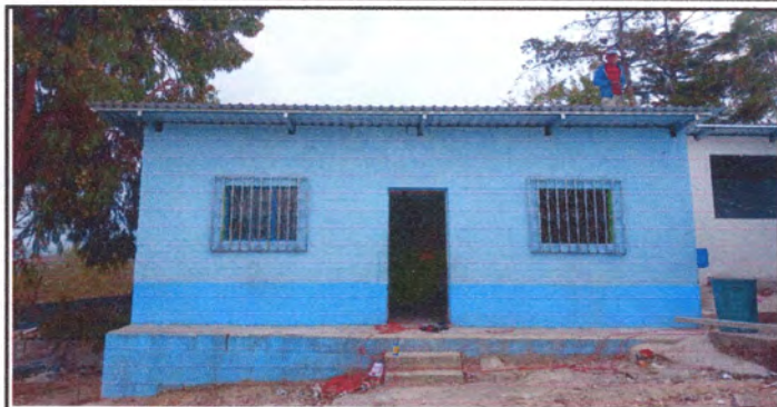
Foto1: Cubierta de lámina
