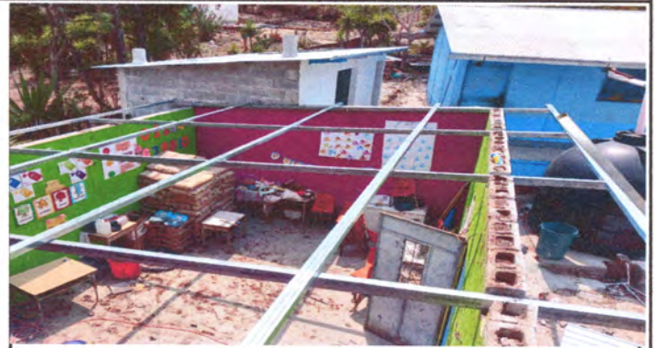
Foto 2: Estructura de techo
