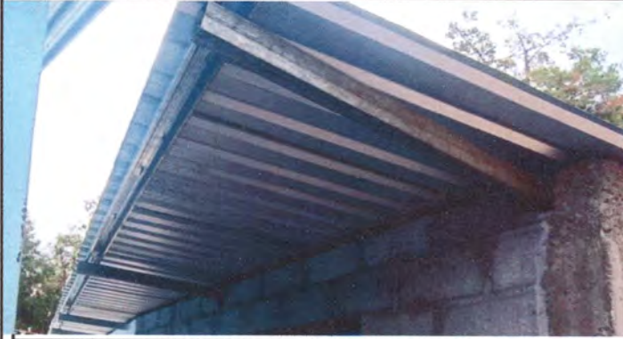
Foto1: Cubierta de lámina
