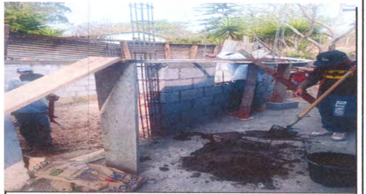
Foto 6: Reparación área de cocina
