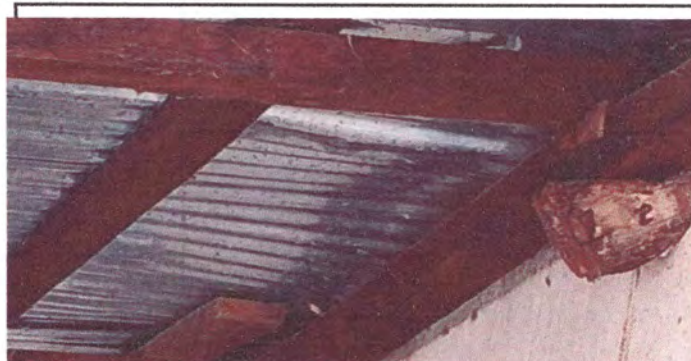
Foto 2: Estructura de techo
