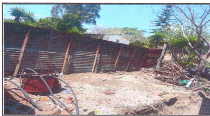
Foto 6: Reparación área de cocina
