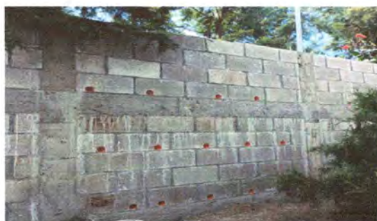
Foto 8: SUSTITUCIÓN MURO DE CONTENCIÓN
