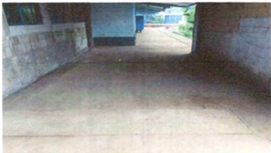
Foto 3: LOSA DE PATIO
