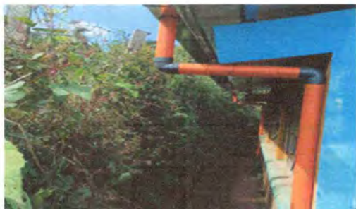
Foto 1: CANALES Y BAJADAS DE AGUA
