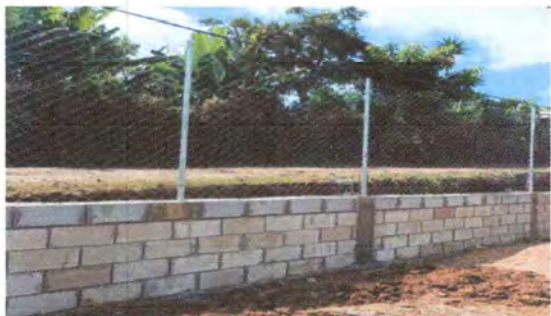
Foto 7: SUSTITUCIÓN CERCO O MURO PERIMETRAL
