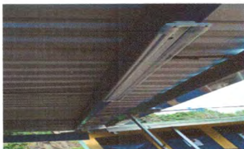
Foto 5: SUSTITUCIÓN DE LAMPARAS
