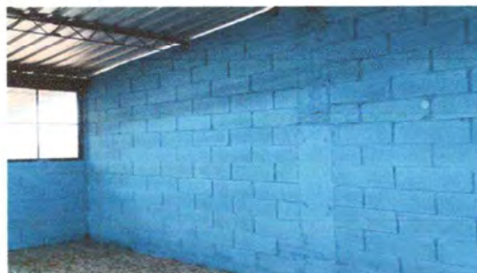
Foto 6: PINTURA DE MUROS INTERIORES Y EXTERIORES
