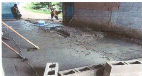
Foto 3: LOSA DE PATIO
