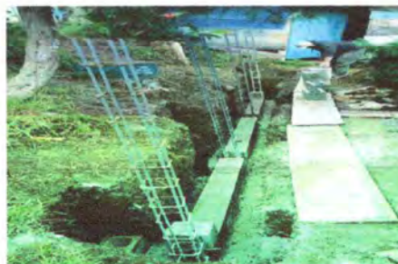
Foto 8: SUSTITUCIÓN MURO DE CONTENCIÓN
