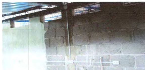
Foto 6: PINTURA DE MUROS INTERIORES Y EXTERIORES
