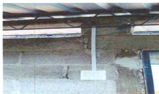
Foto 4: INTERRUPTORES DE LAMPARAS
