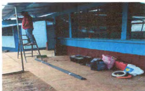
Foto 5: SUSTITUCIÓN DE LAMPARAS
