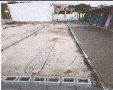
Foto1: SUSTITUCIÓN DE DE LOSA DE PATIO INCLUYE BASE, FUNDICIÓN, Y ACABADO (SE COLOCARÁ UNA CAPA DE 20CM DE BALASTO PARA EVITAR INUNDACIONES)
