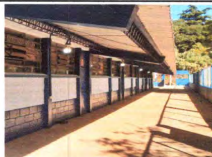
Foto 6: Finalización de reparación del sistema eléctrico y se colocan bombillas.
