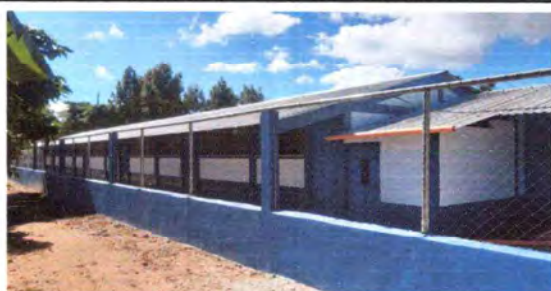
Foto 5.1: finalización de colocación de tubo en la malla para mayor para refuerzo.
