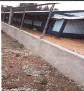
Foto 3: Finalización del repello en paredes de muro perimetral.
