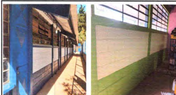
Foto 7: Finalización del pintado de aulas por dentro y fuera.
