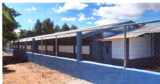
Foto 3.1: Finalización del tallado de 13 columnas en el muro perimetral.
