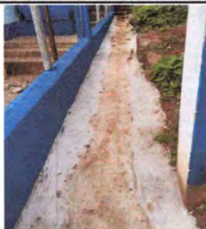
Foto 2: Finalización de cuneta para que fluya el agua de lluvia.
