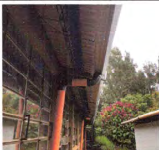
Foto 1: Finalización de instalación de canal y bajadas de agua.
