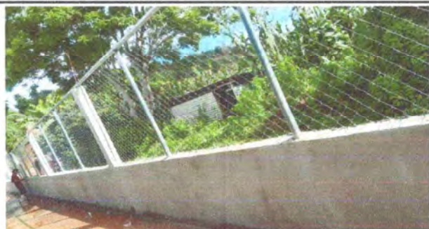
Foto 3: Realizando el repello en paredes de muro perimetral.
