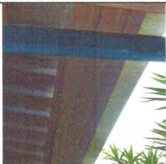
Foto 1: Instalación de canal y bajadas de agua.
