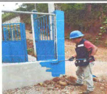
Foto 7.1: Se realiza el pintado de muro perimetral.
