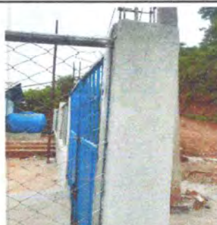
Foto 3.1: Realizando el tallado de 13 columnas en el muro perimetral.
