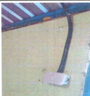
Foto 6.1: Reparando sistema eléctrico colocándole cables, plafoneras, apagadores y toma corrientes.
