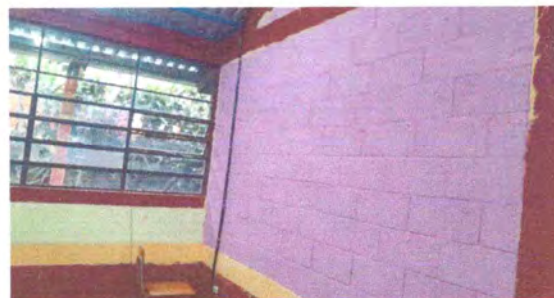
Foto 7: Se realiza el pintado de aulas por dentro y fuera.
