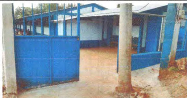
Foto 4: Reparación de losa en rampa al ingreso al establecimiento.
