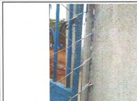
Foto 5.1: Colocando tubo en la malla para mayor refuerzo.
