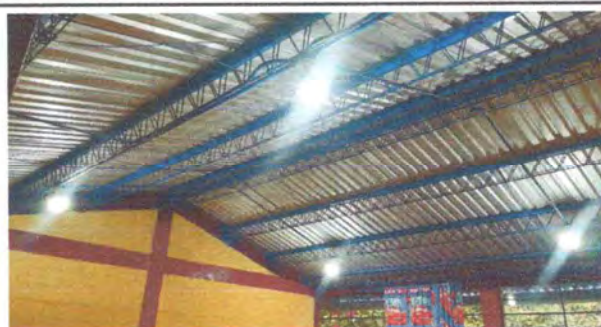
Foto 6: Reparando el sistema eléctrico y se colocan bombillas.
