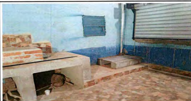
Foto 2: Reparación y sustitución de área de cocina.
