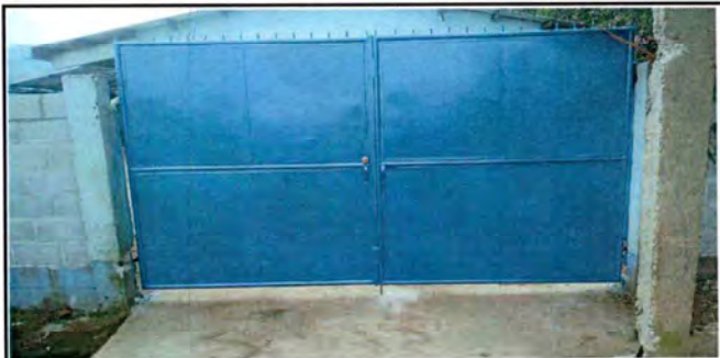
Foto 6: Mantenimiento a portones
