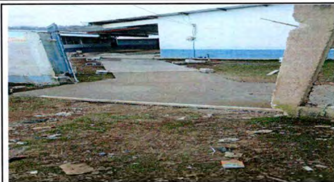
Foto1: Losa de Patio
