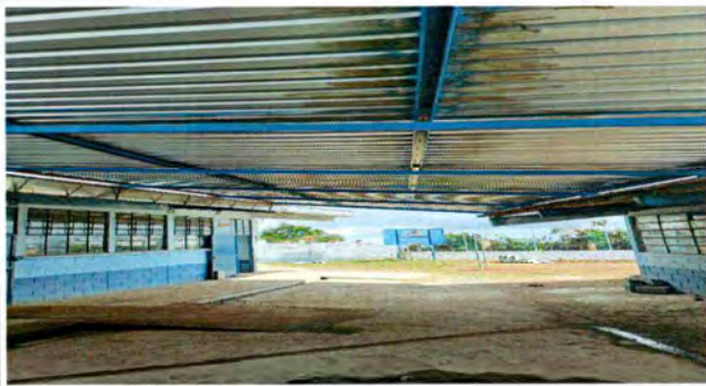
Foto1: Cubierta de Lámina
