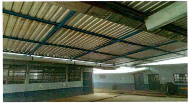
Foto 2: Estructura de Techo
