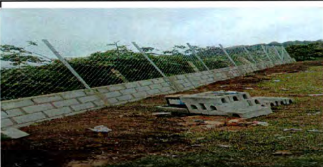
Foto 5: Cerco o muro perimetral
