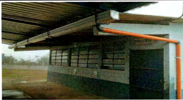
Foto 3: Canales y bajadas de agua pluvial
