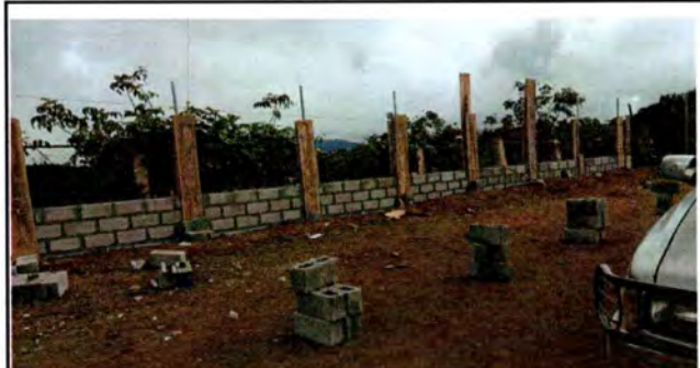
Foto 6: Cerco o muro perimetral
