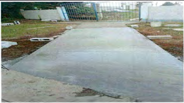
Foto7: Losa de patio
