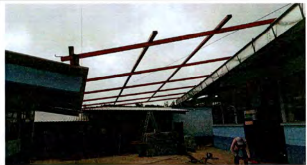
Foto 2: Estructura de Techo
