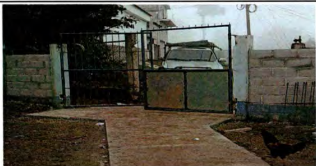
Foto 5: Mantenimiento a portones
