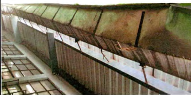
Foto 3: Canales y bajadas de agua Pluvial
