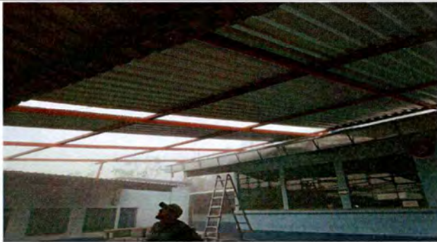
Foto: 1 Cubierta de Lámina
