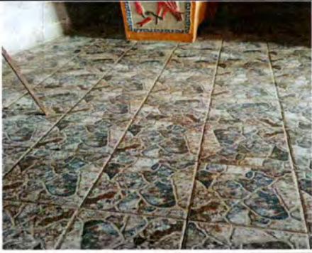
Foto 8: Reparación o sustitución de área de cocina
