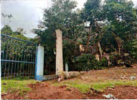
Foto: Muro Perimetral
