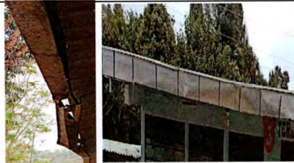
Foto3: Canales y bajadas de agua pluvial
