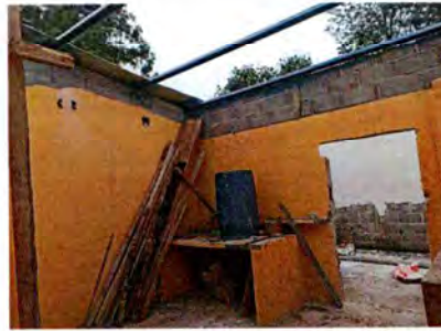
FOTO 2: Mantenimiento de cocina
