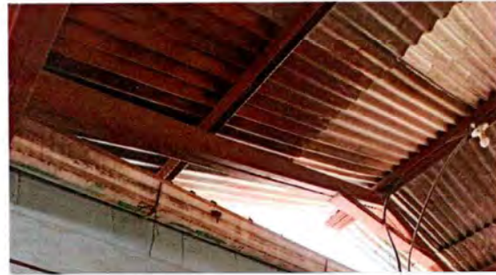
FOTO 2: Estructura de techo
