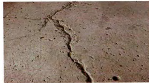
Foto: Losa de patio
