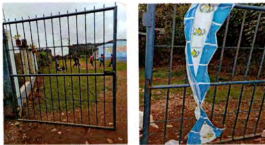
Foto: Mantenimiento de portones
