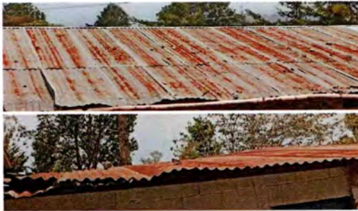
Foto: Cubierta de lamina
