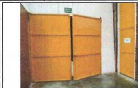
Foto 19: REPARACIÓN Y MANTENIMIENTO A PORTONES SALÓN DE USOS MÚLTIPLES (Sustitución chapa, pasadores, nivelación de portón)
