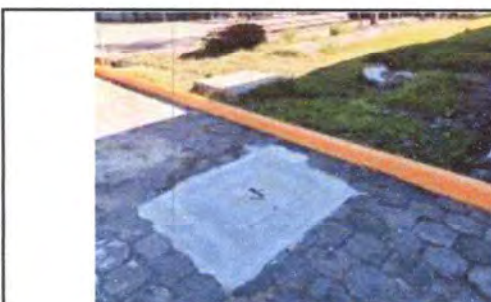
Foto 22: REPARACIÓN Y MANTENIMIENTO DE CISTERNA
