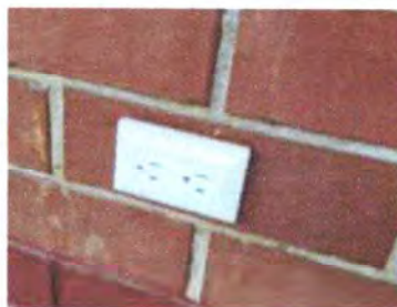
Foto 2: SUSTITUCIÓN DE TOMACORRIENTES EN SALONES DE CLASES
