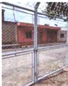
Foto 15: REPARACIÓN Y MANTENIMIENTO A PORTÓN ENTRADA PRINCIPAL
