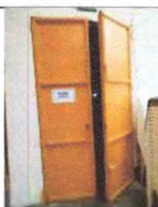
Foto 18: REPARACIÓN Y MANTENIMIENTO A PORTONES SALÓN DE USOS MÚLTIPLES (Sustitución chapa, pasadores, nivelación de portón)
