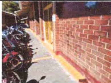
Foto 8: SUSTITUCIÓN DE PINTURA BASE ACEITE (ZOCCALO) TALLERES DE CARPINTERÍA Y METALES FRENTE A PARQUEO 40 MTS2
