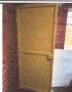
Foto 14: SUSTITUCIÓN DE PUERTAS DEL ÁREA ADMINISTRATIVA
