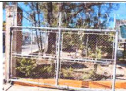
Foto 16: REPARACIÓN Y MANTENIMIENTO A PORTÓN ENTRADA PEATONAL
