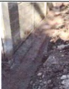
Foto 3: SUSTITUCIÓN DE CUNETETA DE CONCRETO
