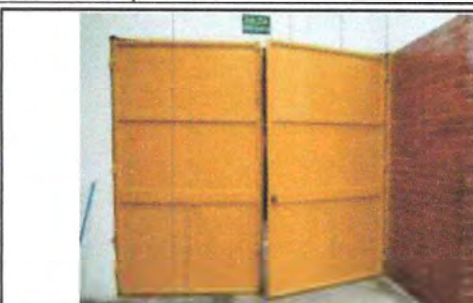
Foto 20: REPARACIÓN Y MANTENIMIENTO A PORTONES SALÓN DE USOS MÚLTIPLES (Sustitución chapa, pasadores, nivelación de portón)
