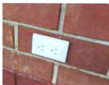
Foto 2: SUSTITUCIÓN DE TOMACORRIENTES EN SALONES DE CLASES
