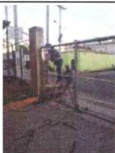
Foto 15: REPARACIÓN Y MANTENIMIENTO A PORTÓN ENTRADA PRINCIPAL
