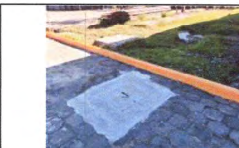
Foto 22: REPARACIÓN Y MANTENIMIENTO DE CISTERNA
