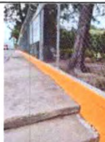
Foto 4: SUSTITUCIÓN DE PINTURA BASE ACEITE (ZOCALO) FRENTE DEL ESTABLECIMIENTO, HACIA EL CAMPO DE FUTBOL 175 MTS2.
