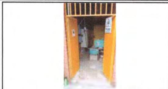
Foto 1: SUSTITUCIÓN DE TRANSFORMADORES DE CORRIENTE TOROIDAL ABB DE 400/5 BIL 10KV CLASE 0,5 INTERMEDIO
