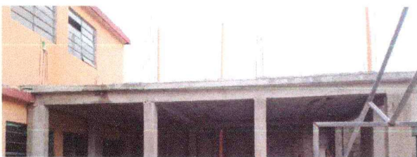
Foto 3: Losa sustituida.
