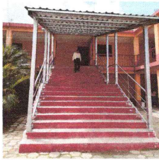
Foto 2: Estructura metálica para techo de lámina completa sustituida.
