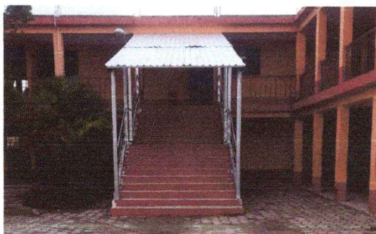
Foto1: Cubierta de lámina troquelada sustituida.
