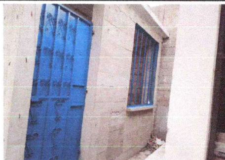
Foto 6: Puerta y balcones instalados.
