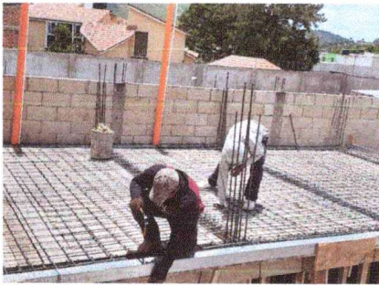
Foto 3: Fundición de losa.
