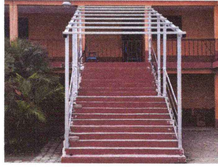
Foto 2: Estructura para la instalación de techo de lámina, definitivo.
