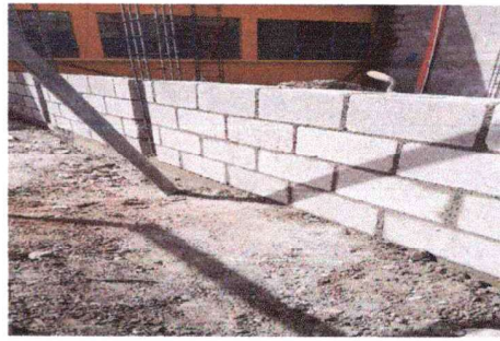
Foto 4: Levantamiento de muro.
