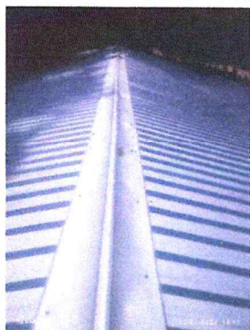
Foto 1: CUBIERTA DE LAMINA (incluye tornillos y capote)
