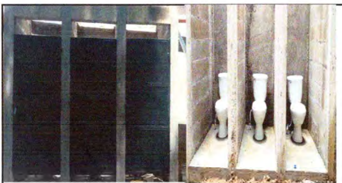
Foto 5: SE OBSERVAN REPARACION DE PAREDES NUEVAS E INSTALACION DE SANITARIOS LAVABLES
