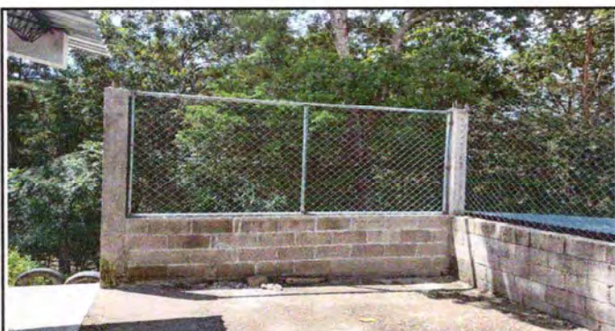
Foto 3: SE OBSERVA FINALIZADO EL MURO DE BLOCK CON MALLA
