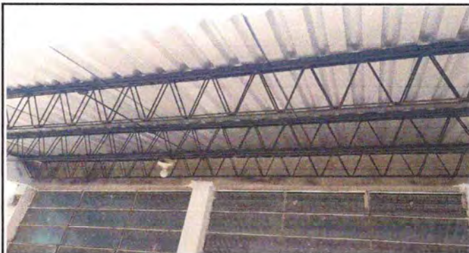
Foto1: INSTALACION DE REFUERZO DE ESTRUCTURA FINALIZADO
