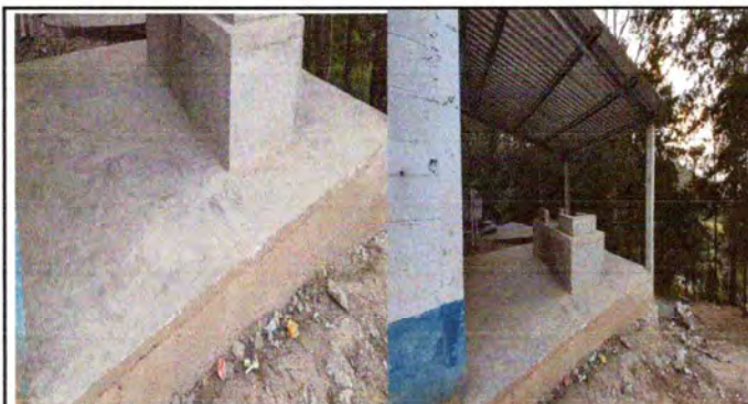
Foto 3: SE OBSERVA FINALIZADA TORTA DE CONCRETO EN AREA DE COCINA Y TECHO INSTALADO EN AREA DE COCINA
