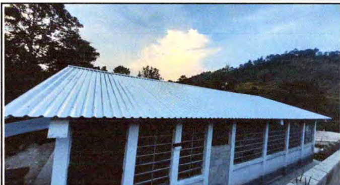
FOTO 2: SE OBSERVA LA LAMINA INSTALADA EN SU TOTALIDAD
