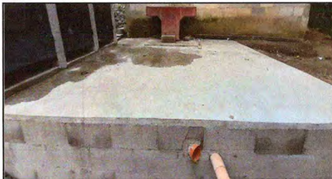
FOTO 2: SE OBSERVA LOSA DE PATIO FINALIZADA
