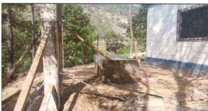
Foto 6: VISTA DE COCINA EN PROCESO DE REMODELACION
