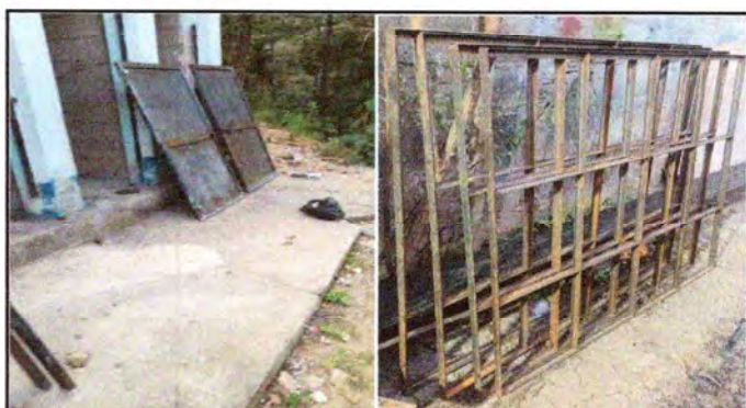
Foto 4: VENTANALES EN PROCESO DE FABRICACION Y REPARACION DE PUERTAS DE METAL
