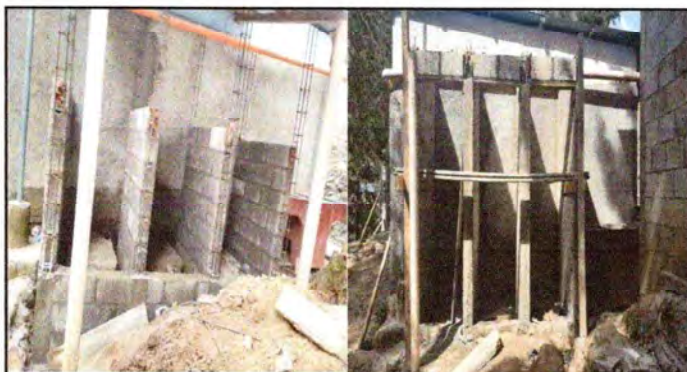
Foto 3: SE OBSERVAN AVANCES EN REPARACION DE PAREDES E INTALACION DE SANITARIOS
