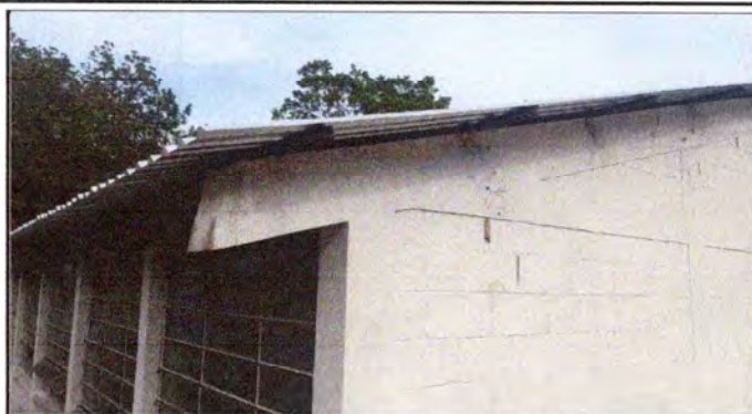
FOTO 2: SE OBSERVA LA LAMINA EN PROCESO DE INSTALACION
