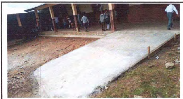
Foto:18 Sustitución de losa de patio finalizada
