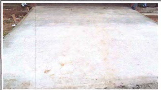
Foto:16 Sustitución de losa de patio
