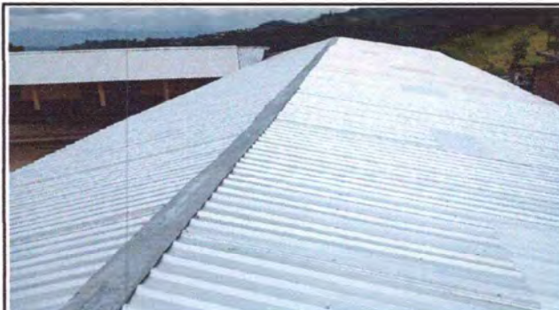
Foto: 2 Lamina troquelada sustituida en las aulas
