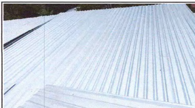
Foto: 4 Lamina troquelada instalada en cocina
