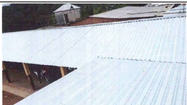
Foto: 3 Lamina troquelada sustituida en corredor y bodega
