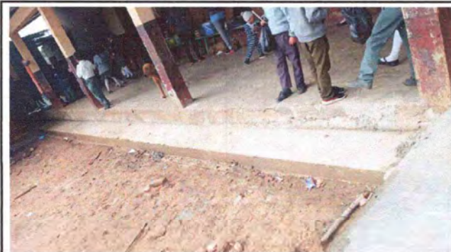
Foto:15 Sustitución de losa de patio realizada
