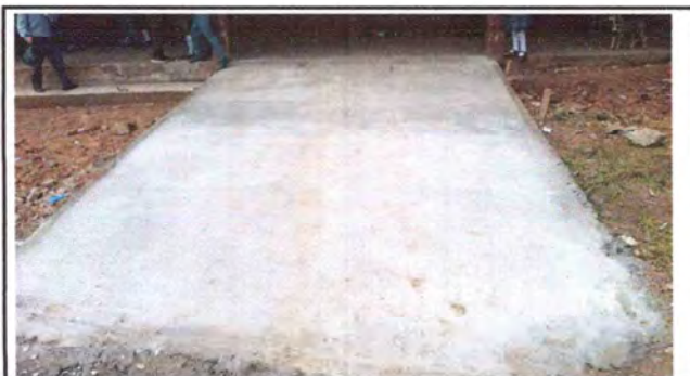
Foto:17 Sustitución de losa de patio finalizada
