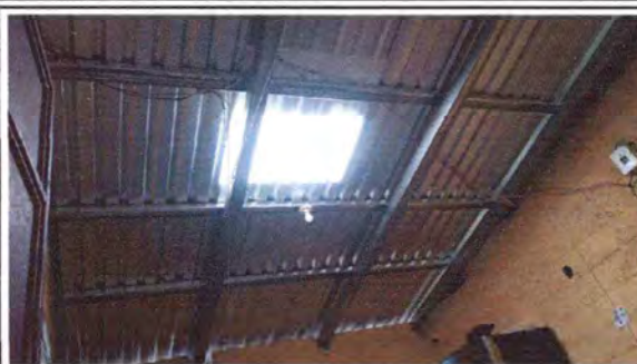
Foto: 8 Sustrucción de lamina troquelada y estructura de madera por estructura de costaneras realizada en direccin del establecimiento
