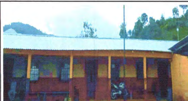
Foto: 1 Lamina troquelada sustituida en el establecimiento
