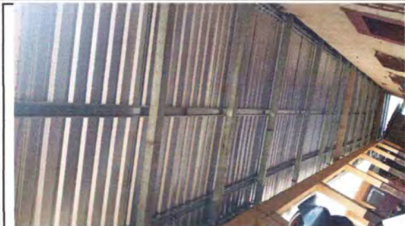
Foto: 7 Sustrucción de estructura de madera por estructura de costaneras realizada en corredor del establecimiento
