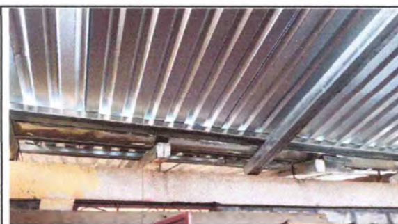
Foto: 10 Canal instalado
