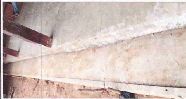
Foto:14 Sustitución de losa de patio realizada
