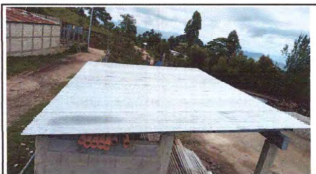
Foto: 5 Lamina acanalada ya existente reinstalada
