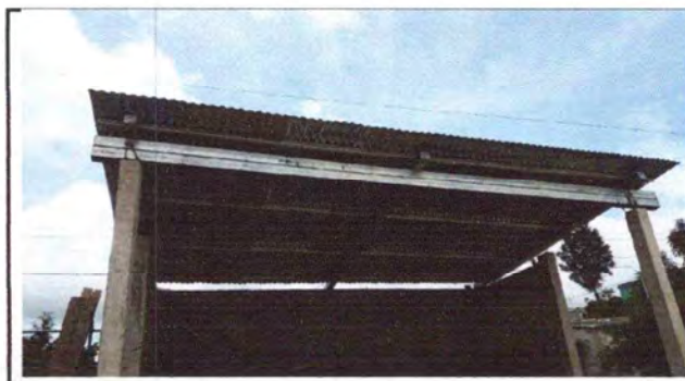
Foto: 6 Sustitución de estructura de madera por costaneras en escenario
