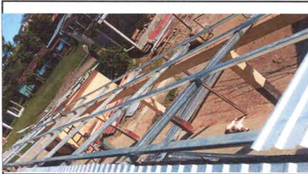
Foto: 7 estructura de costaneras en corredores y aulas
