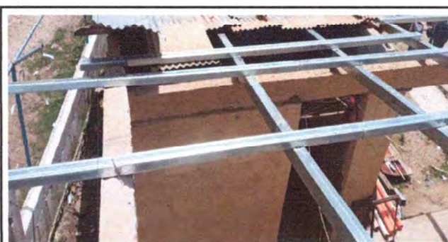
Foto: 6 Instalación de estructura de costaneras en corredor
