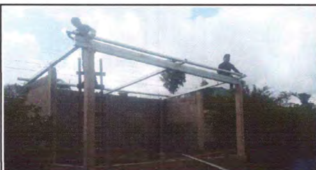
Foto: 4 Inicio de instalación de vigas de metal
