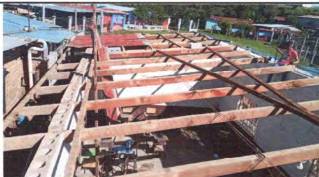
Foto: 3 Desmontaje de estructura de madera dañada
