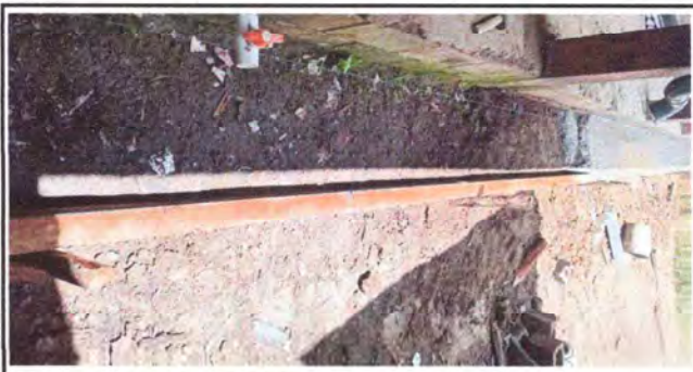
Foto: 11 iniciando fundición de losa de patio
