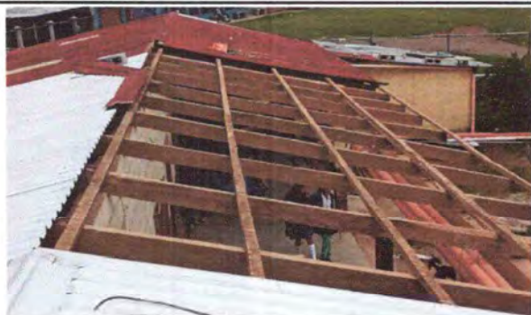
Foto: 1 Inicio del desmontaje de lamina en corredores
