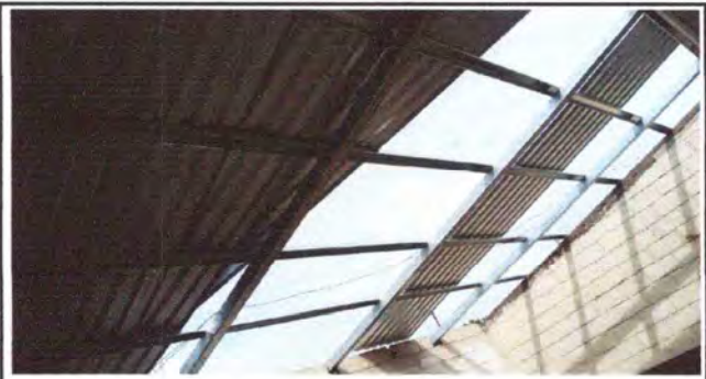
Foto: 8 instalación de lamina troquelada
