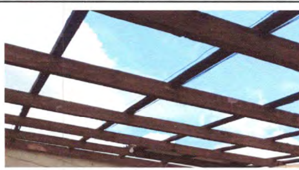
Foto: 2 desmontaje de lamina en aula para reemplazo de estructura
