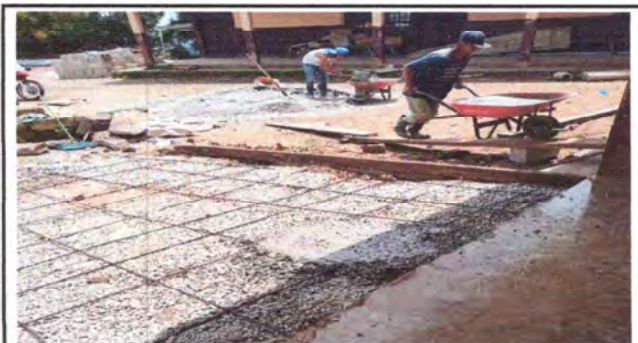
Foto: 10 fundición de losa de patio con refuerzo de hierro
