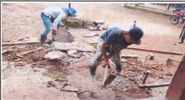
Foto: 9 inicio de retiro de losa de patio dañada
