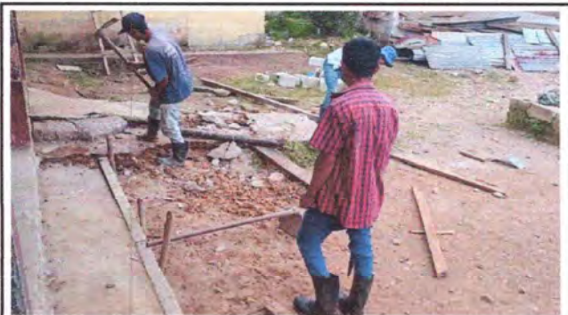
Foto: 10 retirando losa de patio
