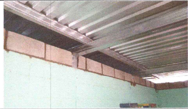
Foto 2: SUSTITUCION DE ESTRUCTURA DE TECHO
