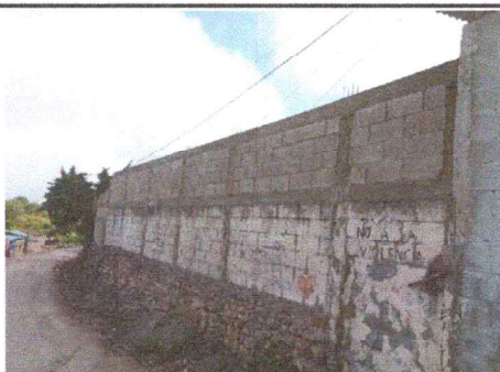
Foto 5: SUSTITUCIÓN DE CERCO PERIMETRAL
