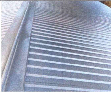
Foto1: SUSTITUCIÓN DE LÁMINA TROQUELADA CALIBRE 26
