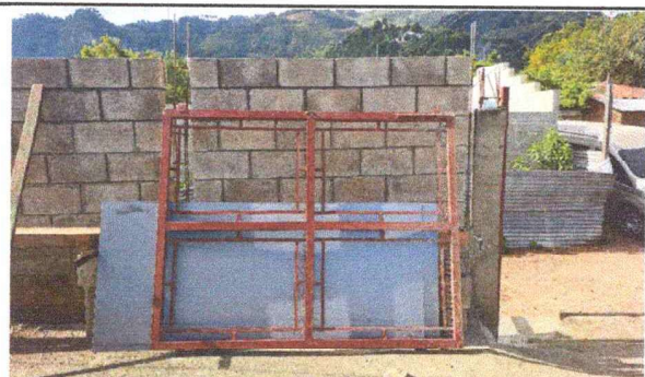
Foto 4: REPARACION Y MANTENIMIENTO A PORTON
