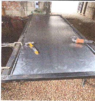
Foto 3: SUSTITUCIÓN DE PUERTAS EN AREA DE AULAS
