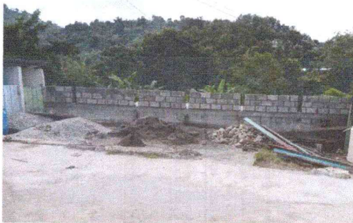
Foto 5: SUSTITUCIÓN DE CERCO PERIMETRAL
