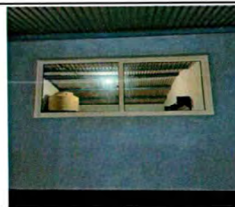
Reparación de Repello Finalizado.
