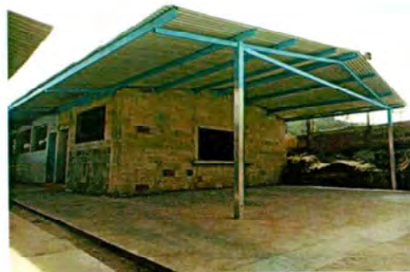
Estructura de Techo Finalizado.
