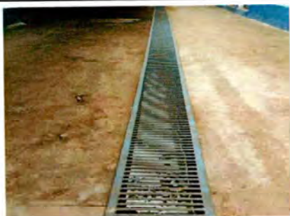
Parrilla Colocada en la Cuneta de Concreto.
