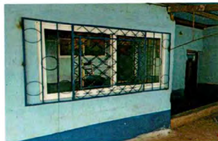
Ventana Instalada en una Aula.
