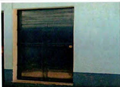
Puerta de la Cocina ya Colocada.
