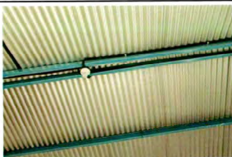
Cubierta de Lámina Terminada.
