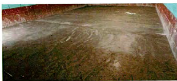
Piso de Cemento Terminado de una Aula.
