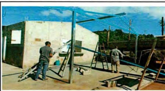
Trabajando la Estructura del Techo
