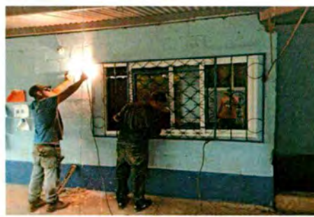
Instalando la Ventana del Aula
