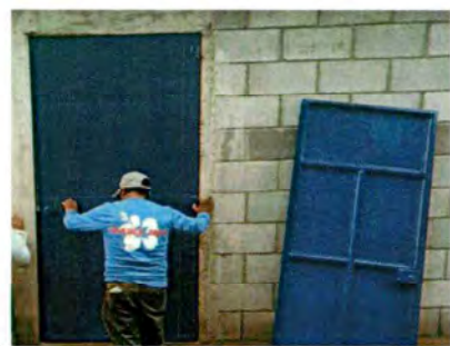
Colocando la Puerta de la Cocina
