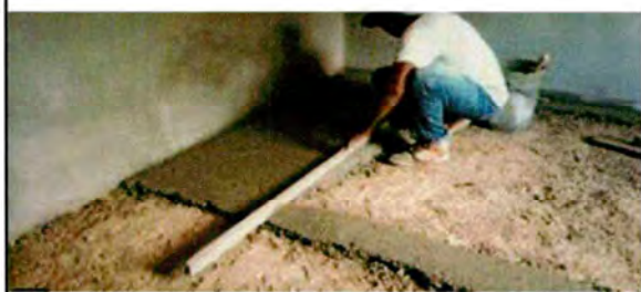
Fundiendo el Piso de Cemento
