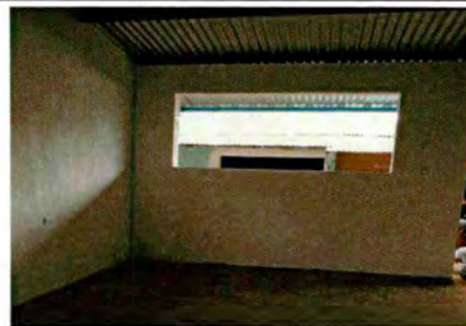
Ampliación de una Ventana de la Cocina.
