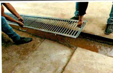
Instalando Parrilla en la Cuneta de Concreto
