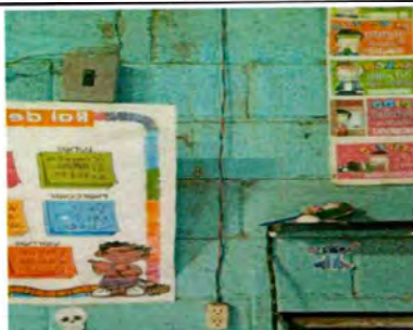
Colocando Material del Sistema Eléctrico
