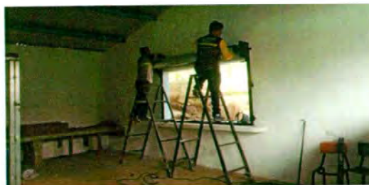
Instalando Persiana en la ventana de la Cocina.
