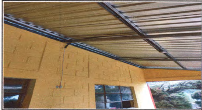
FOTO 2: Suministro y repación de sistema eléctrico
