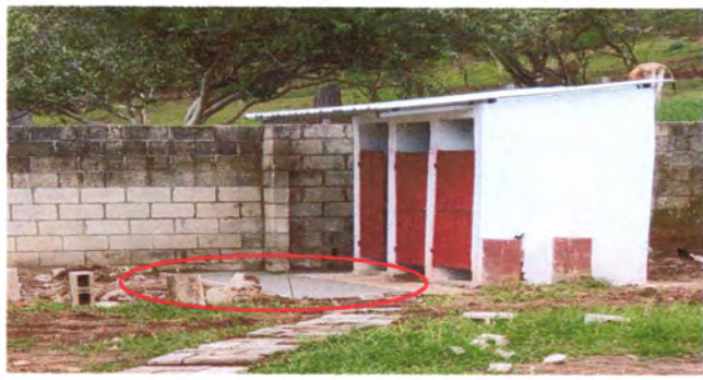
Foto3: Mantenimiento de fosa séptica.
