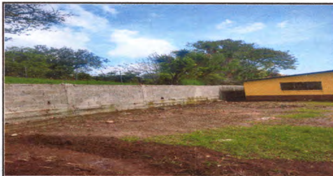
Foto: 5 Repaación de muro de contención
