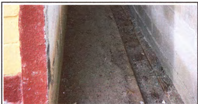
Foto: 6 Mantenimiento y repación de drenajes.
