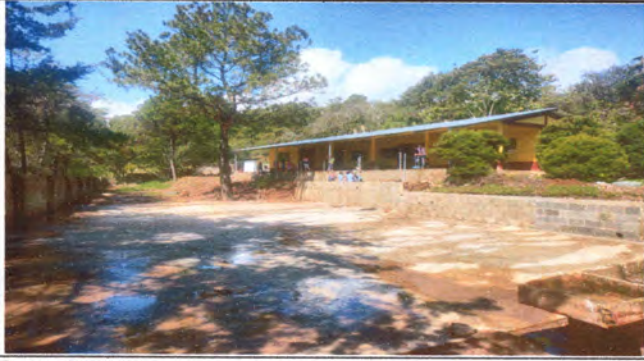
Foto1: Suministro y reparación de losa de patio
