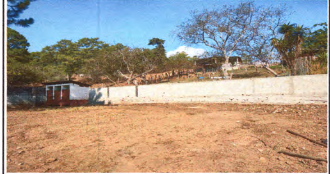
Foto4: suministro y reparación de muro de contención.
