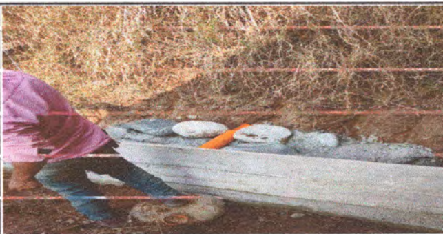
Foto: 5 Repaación de muro de contención
