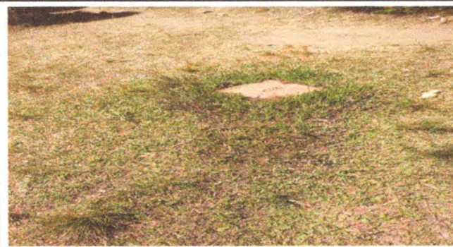
Foto3: Mantenimiento de fosa séptica.
