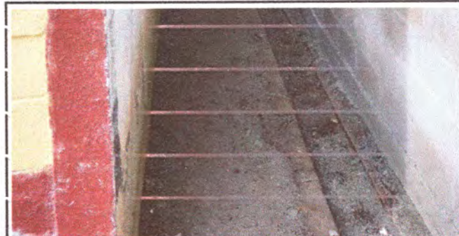
Foto: 6 Mantenimiento y repación de drenajes.
