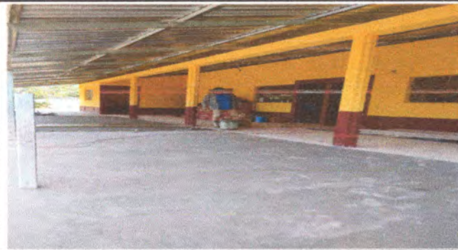
Foto1: Suministro y reparación de losa de patio
