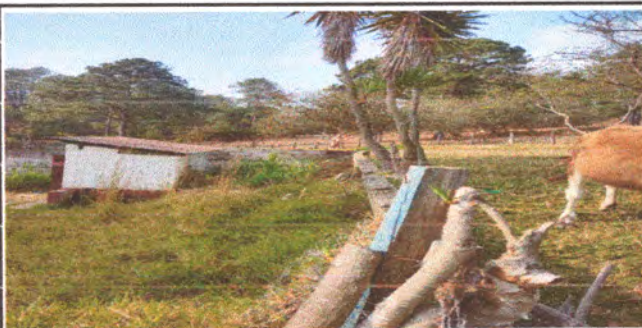
Foto: 5 Repaación de muro de contención
