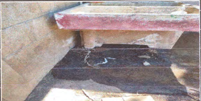
Foto: 6 Mantenimiento y repación de drenajes.
