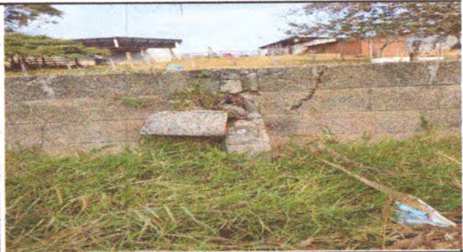
Foto4: suministro y reparación de muro de contención.
