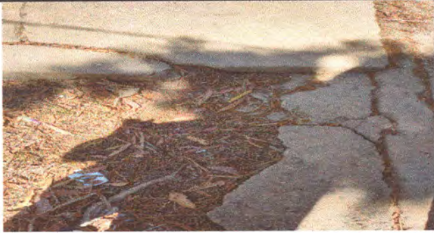
Foto1: Suministro y reparación de losa de patio
