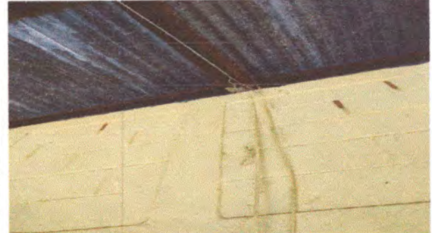
FOTO 2: Suministro y repación de sistema eléctrico
