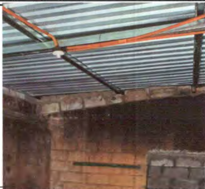
Foto 1: La cubierta de lámina y la estructura de techo ya fue cambiada en su totalidad
