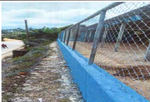
Foto 3: La malla fue instalada en su totalidad
