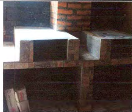
Foto 8: Las planchas ya fueron instaladas
