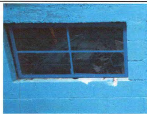
Foto 10: El ventanal ya fue instalado
