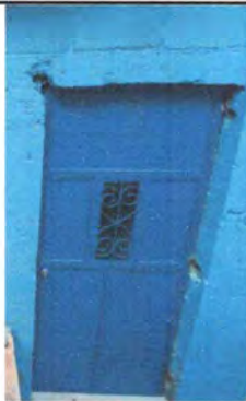
Foto 9: La puerta ya fue instalada
