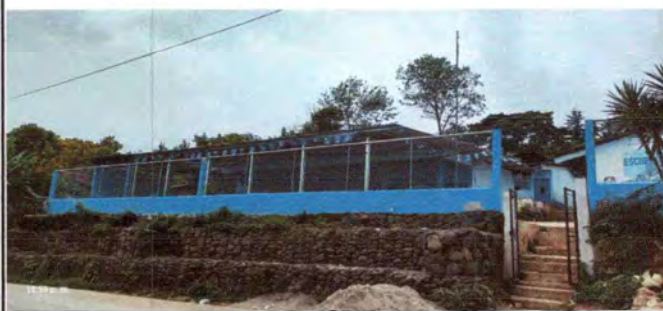
Foto 2: La base del muro perimetral ya fue terminada y pintada.
