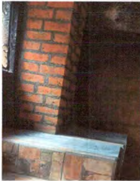
Foto 7: La chimenea ya fue reconstruida totalmente
