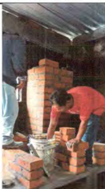
Foto 7: Reconstrucción de la chimenea
