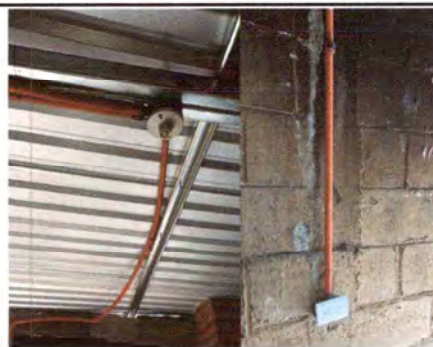
Foto 6: se observa el cambio de cableado eléctrico, cambio de plafonera y tomacorrientes
