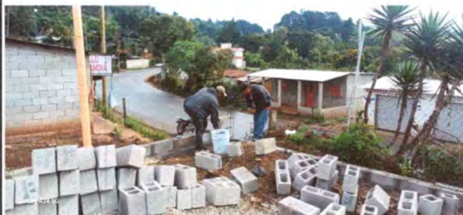
Foto 2: Se puede observar el avance del reforzamiento de la base del muro perimetral
