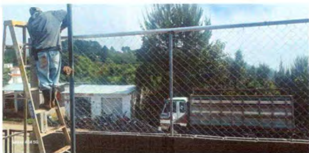
Foto 3: colocación de la malla nueva
