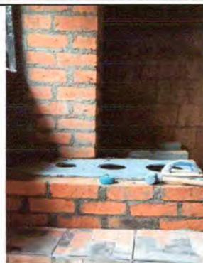
Foto 8: Instalación de las planchas.
