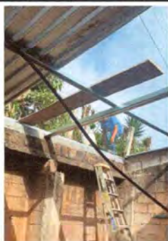
Foto 1: Se puede observar el camio de estructura metálica y el inicio del cambio de lámina
