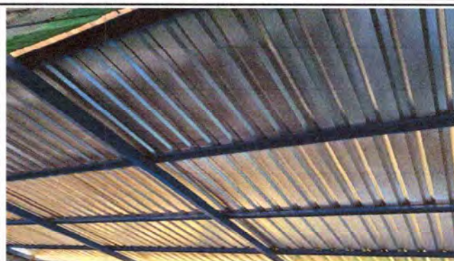
Foto 2: INSTALACION DE ESTRUCTURA DE METAL Y LAMINA TROQUELADA TERMINADA. (VISTA INTERIOR)
