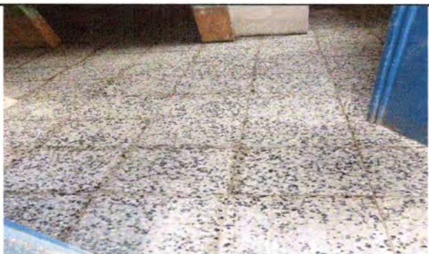
Foto 3: SUSTITUCION DE PISO DE GRANITO COMPLETADA.
