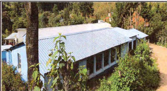
Foto1: INSTALACIÓN DE ESTRUCTURA DE METAL Y LÁMINA TROQUELADA TERMINADA. (VISTA EXTERIOR)
