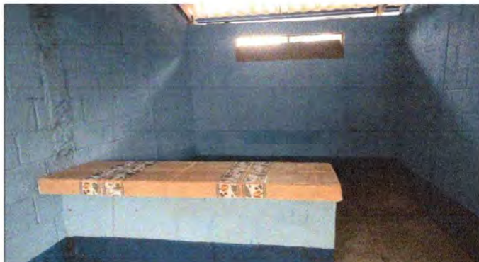
Foto 4: AREA DE COCINA Y VENTANAS TERMINADAS
