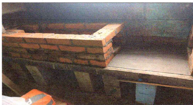
Foto 6: SUSTITUCIÓN DE AREA DE ESTUFA RURAL Y CHIMENEA
