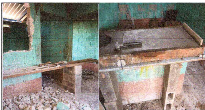
Foto 5: SUSTITUCION DE AREA DE COCINA Y VENTANA
