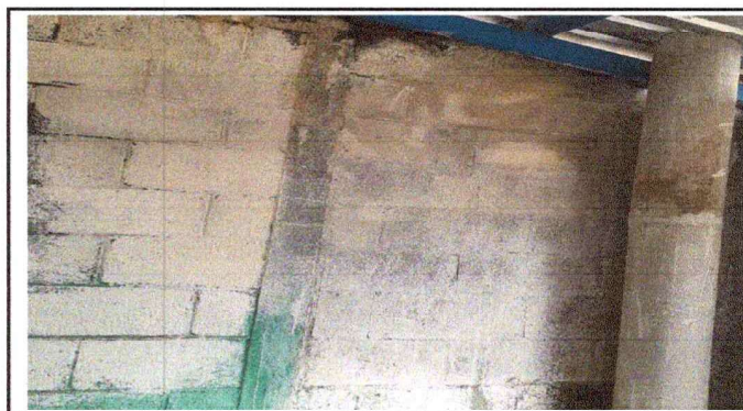
Foto 4: REPARACION DE AREA DE VENTANA
