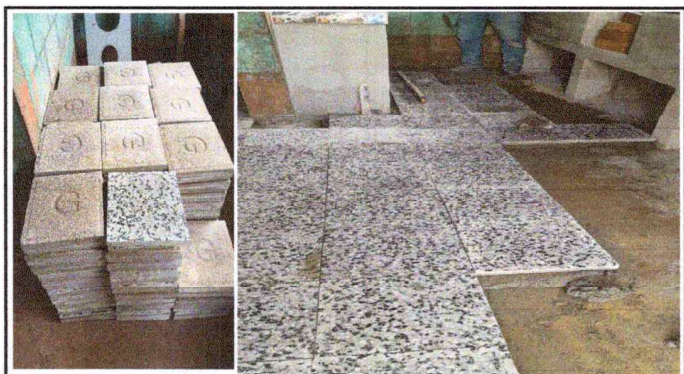
Foto 3: INSTACION DE PISO DE GRANITO
