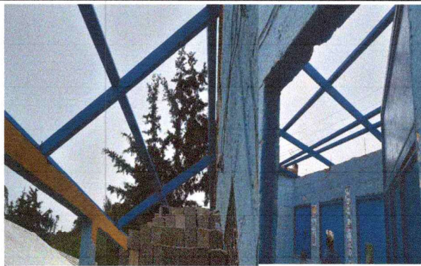
Foto 2: INSTALACION DE ESTRUCTURA PARA ANCLAJE DE LAMINA
