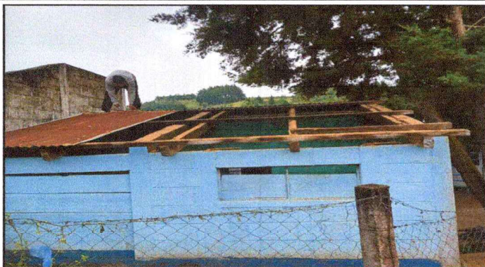
Foto1: DESMONTAJE DE LAMINA Y MADERA EXISTENTE
