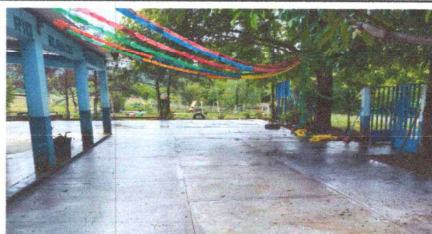
Foto 2: Vista final de la reparación, fundición y acabados, de la losa de patio juntamente a la reparación de drenajes y tuberías de agua potable.
