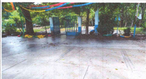
Foto 1: VISTA FINAL DE REPARACIÓN, FUNDICIÓN, ACABADOS DE LOSA DE PATIO.
