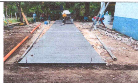
Foto 4: REPARACIÓN, FUNDICIÓN, ACABADOS DE LOSA DE PATIO.
