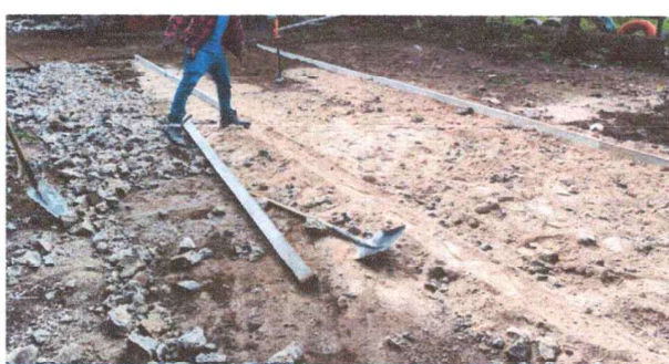
Foto 3: REPARACIÓN, FUNDICIÓN, ACABADOS DE LOSA DE PATIO.
