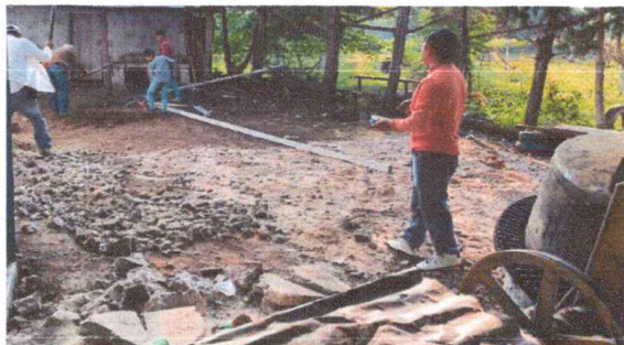
Foto 1: REPARACIÓN, FUNDICIÓN, ACABADOS DE LOSA DE PATIO.
