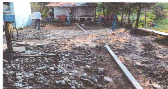
Foto 2: REPARACIÓN, FUNDICIÓN, ACABADOS DE LOSA DE PATIO.
