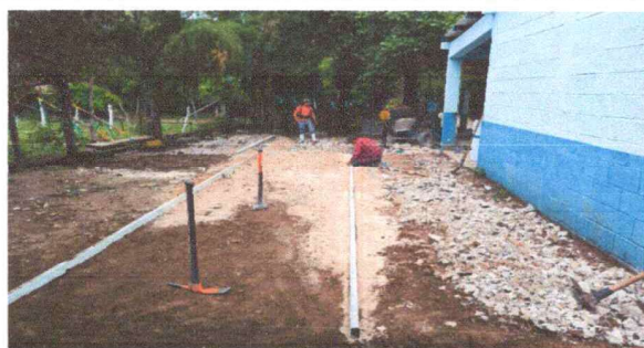
Foto 5: REPARACIÓN, FUNDICIÓN, ACABADOS DE LOSA DE PATIO.
