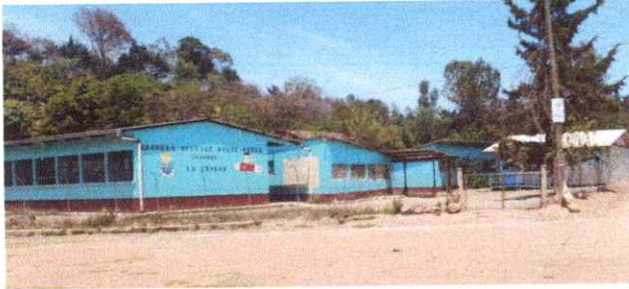
Foto 12: Fotografía del establecimiento
