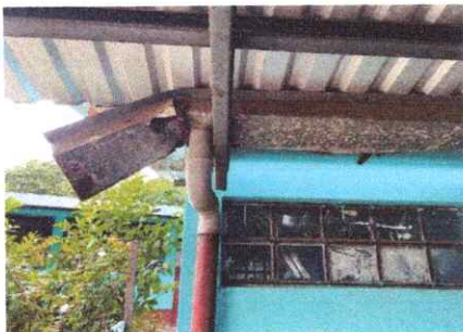
Foto 1: Se observa la necesidad de cambiar canales y bajadas de agua, para evitar el riesgo de ocasionar accidentes.
