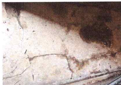
Foto 11: Losa de patio y Cocina en mal estado, se removerá y construirá nuevamente.
