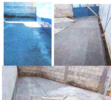
Foto 8: Losa de patio completa
