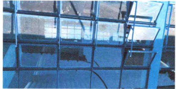
Foto 2: Sustitución de vidrios completa.
