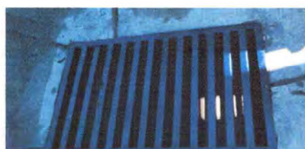
Foto 11: Rejilla de drenaje instalada
