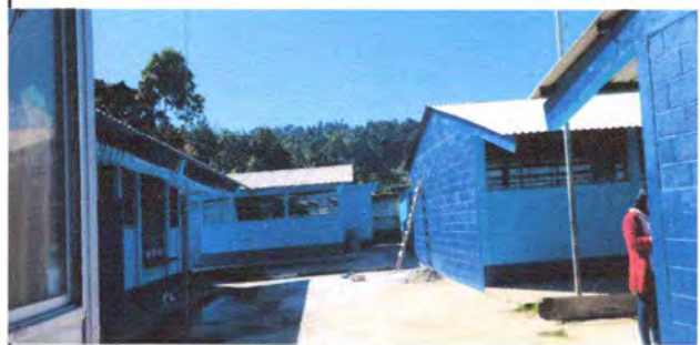
Foto 6: pintura de interiores y exteriores
