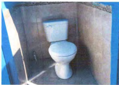
Foto 3: instalación de baños y azulejo.
