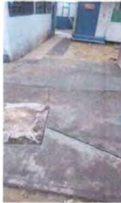
Foto 7: Sustrucción de losa de patio
