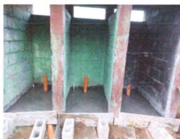
Foto 3: Sustitución de baños
