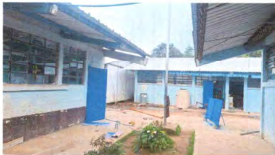
Foto1: Reparación de puertas de aulas y de baños
