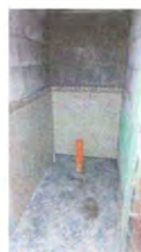
Foto 6: Sustitución de azulejo
