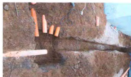
Foto 4: instalación de drenajes
