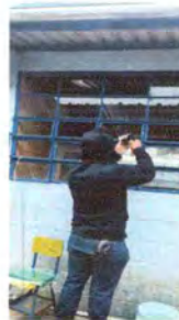
Foto 2: Sustitución de vidrios
