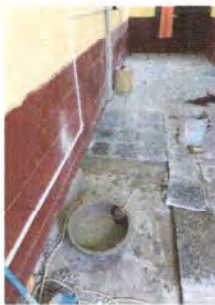
Foto 9: sustrucción de piso
