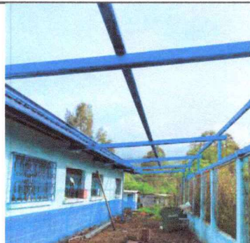
Foto 2: Avances en la instalación de la estructura del techo.
