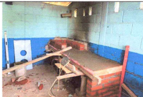
Foto 4: Avances en la instalación de estufa rural.
