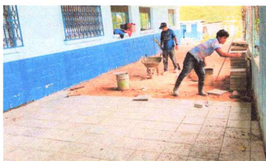
Foto 3: Se observan los avances en la instalación del piso de granito.
