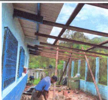
Foto1: Preparando el techo para la próxima instalación de lámina troquelada.
