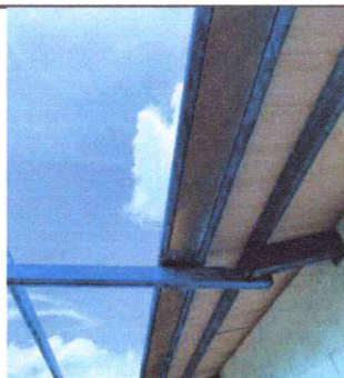
Foto 5: Se observan los avances en la instalación del canal.
