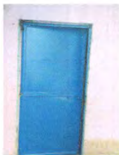
Foto 3: SUSTITUCION DE PUERTA (2*1MTS)
