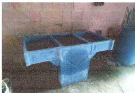
Foto 1: COCINA (sustitucion de pila)
