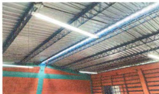
Foto 4: SUSTITUCION DE LAMPARA LED INCLUYE INTERRUPTOR
