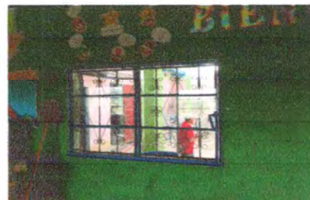
Foto 6: SUSTITUCION VENTANAS (1.25*0.80mts)
