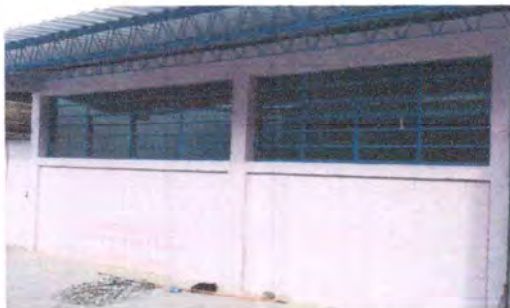
Foto 5: SUSTITUCION DE VENTANAS (3.40*1.10 mts)
