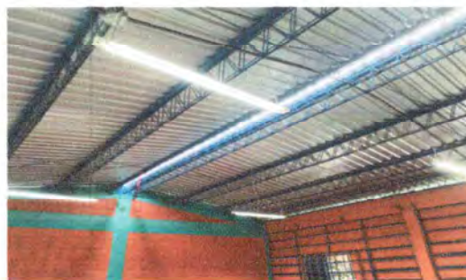
Foto 2: REPARACION DE ESTRUCTURA DE TECHO
