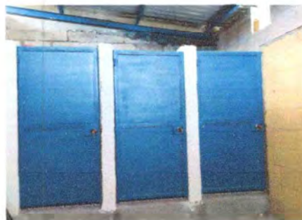
Foto 4: SUSTITUCION DE PUERTA (1.56*0.80mts)
