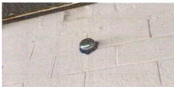
Foto 3: REPARACION DE SISTEMA ELECTRICO (sustitucion de timbre)
