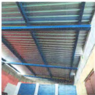
Foto 1: SUSTITUCION DE CUBIERTA DE LAMINA (TROQUELADA CALIBRE 26)
