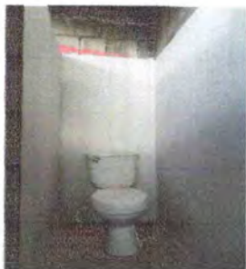
Foto1: REPARACION DE REPELLO Y CERNIDO
