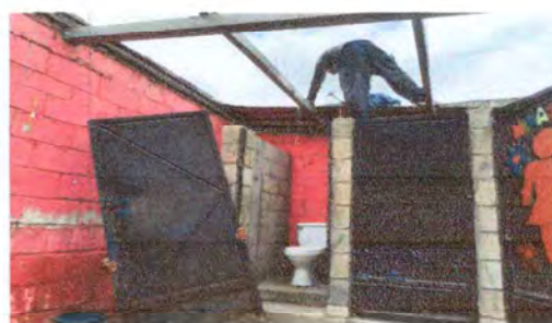
Foto 4: SUSTITUCION DE PUERTA (1.50*0.80mts)
