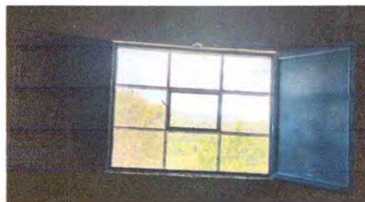
Foto 6: SUSTITUCION VENTANAS (1.25*0.80mts)
