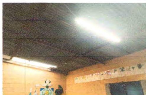
Foto 4: SUSTITUCION DE LAMPARA LED INCLUYE INTERRUPTOR
