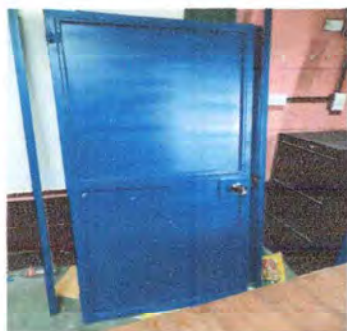
Foto 3: SUSTITUCION DE PUERTA (2*1MTS)
