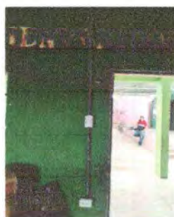
Foto 5: SUSTITUCION DE TOMACORRIENTES
