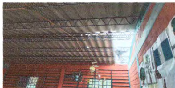
Foto 2: REPARACION DE ESTRUCTURA DE TECHO
