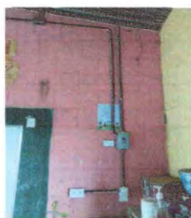
Foto 3: REPARACION DE SISTEMA ELECTRICO (sustitución de timbre)
