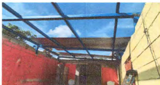
Foto 1: SUSTITUCION DE CUBIERTA DE LAMINA (TROQUELADA CALIBRE 26)
