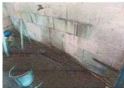
Foto 2: REPARACION DE DRENAJE
