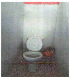
Foto1: REPARACION DE REPELLO Y CERNIDO
