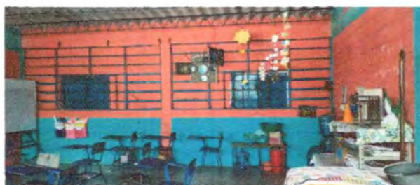
Foto 5: SUSTITUCION DE VENTANAS (3.40*1.10 mts)
