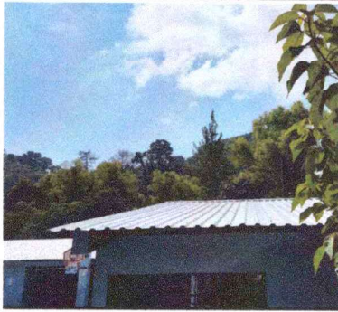
Foto1: Techo de modulo de Direccion reparado
