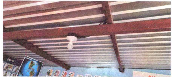
Foto 2: Sistema eléctrico en aula reparado
