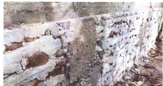
Foto 4: Muro de contencion reparado
