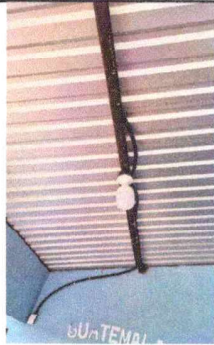
Foto 3: Sistema eléctrico en corredor reparado
