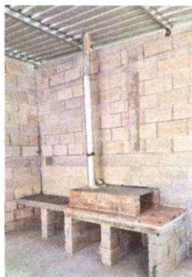
Foto 5: Área de cocina reparada
