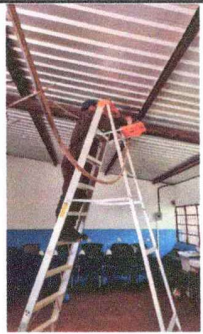
Foto 3: Desinstalación de Sistema Eléctrico
