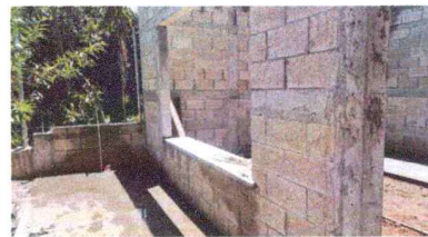
Foto 6: Reparaciones en área de cocina
