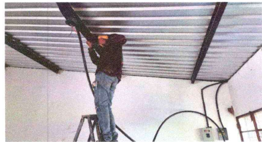
Foto 4: Instalación de Sistema Eléctrico nuevo
