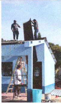
Foto1: Retiro de cubierta en área de Dirección
