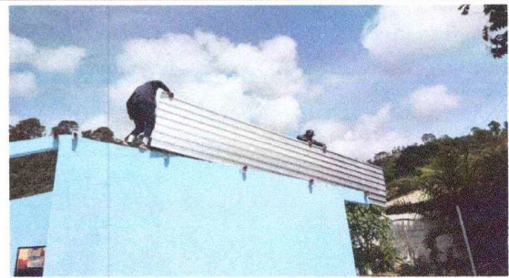
Foto 2: Colocación de cubierta en área de Dirección
