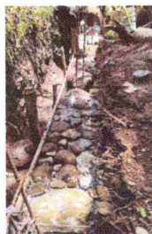
Foto 5: Reparación de muro de contención
