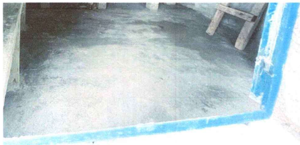
Foto 1: INSTALACION Y FUNDICION DE PISO DE CONCRETO TIPO ALISADO
