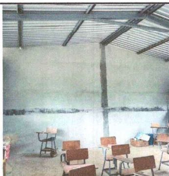
Foto 5: INSTALACION DE REPELLO TIPO BASE
