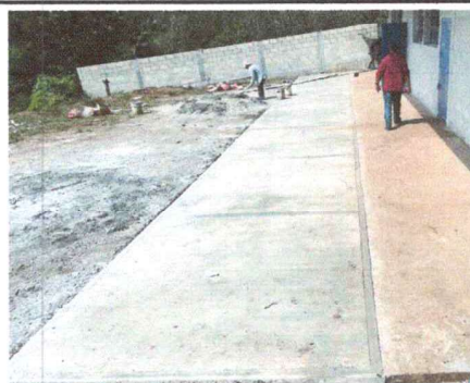
Foto 4: FUNDICION DE LOSA DE CONCRETO
