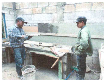
Foto 6: REPARACIÓN DEL AREA DE COCINA
