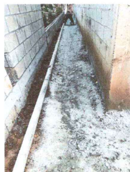
Foto 2: PREPARACION DEL AREA DONDE SE FUNDIRA LA CUNETA
