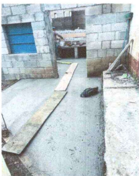
Foto 1: INTALACION DE PISO TIPO ALIZADO EN AREA DE COCINA
