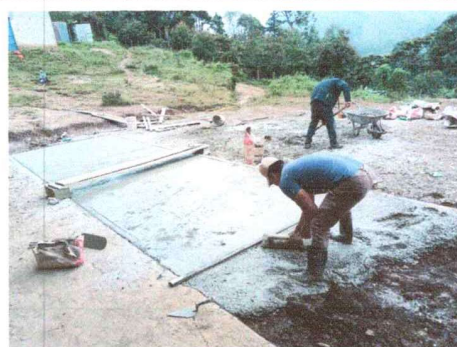
Foto 4: FUNDICION DE LOSA DE CONCRETO
