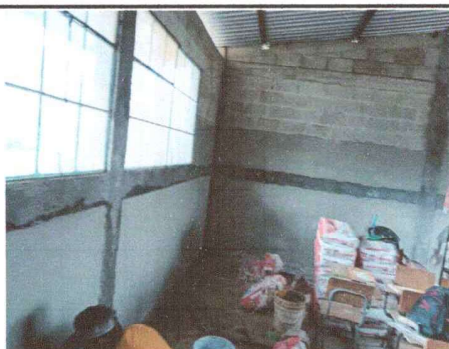
Foto 5: INSTALACION DE REPELLLO CON MATERIAL TIPO BASE
