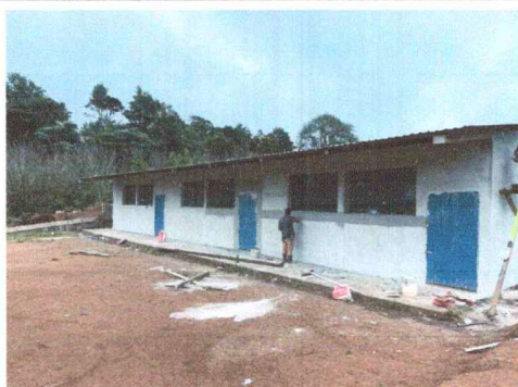
Foto 3: PREPARANDO EL AREA DE MUROS PREVIO A PUNTURA
