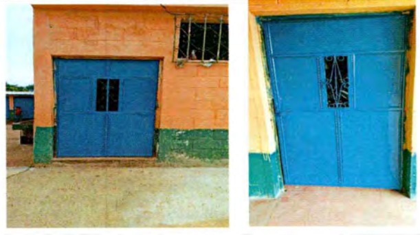
FOTO 8: Instalación de chapas y pintura en puertas.
