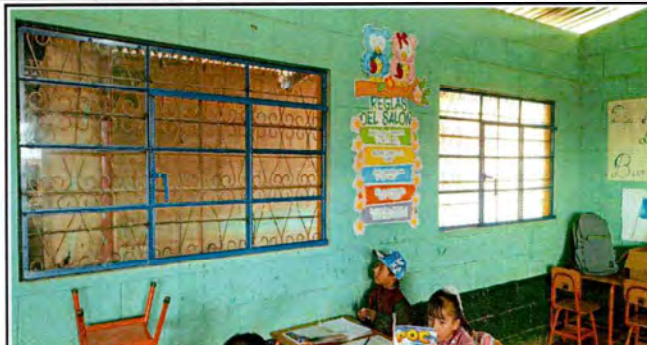
FOTO 2: Instalación de ventanas.
