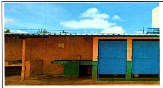
Foto4: Instalación de pila en área de baños
