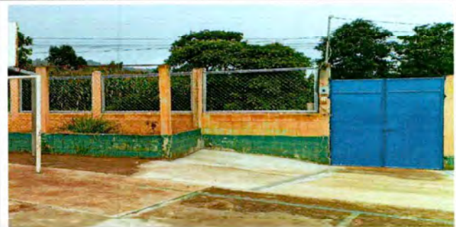
Foto: 12 Sustitución losa de patio ingreso principal.
