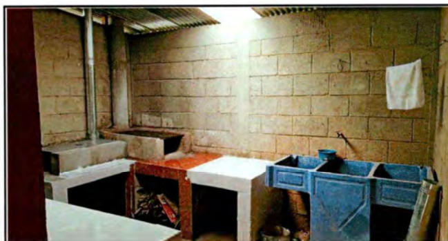
Foto3: Reparación y mantenimiento de área de cocina
