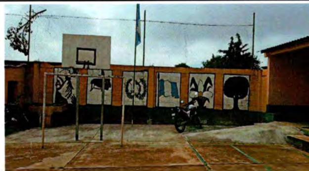
Foto 9: Reparación de losa de patio
