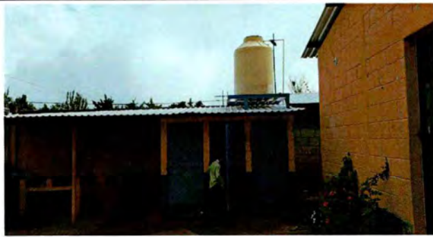
Foto7: Instalación de tinaco
