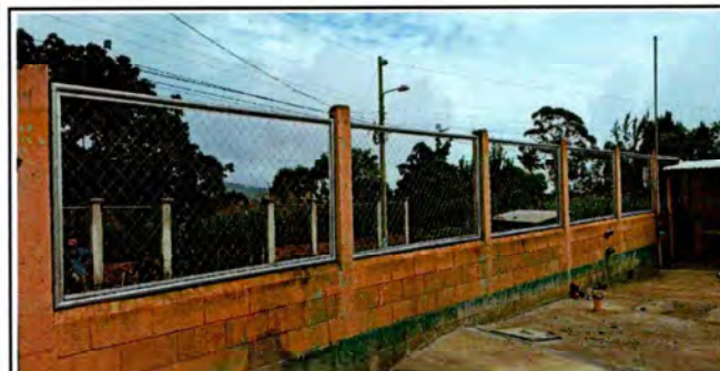
Foto: 5 Sustitución de malla metálica en el entorno.
