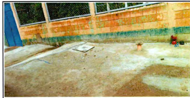
Foto: 6 Sustitución de fosa séptica.
