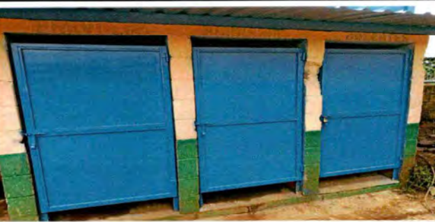
Foto: 11 Sustitución de puertas en sanitarios.
