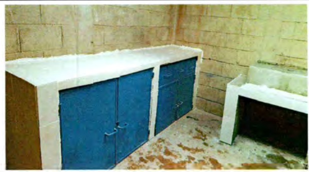
Foto 10: Mantenimiento y reparación área de cocina.
