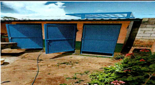
Foto: 11 Sustitución de puertas en sanitarios.
