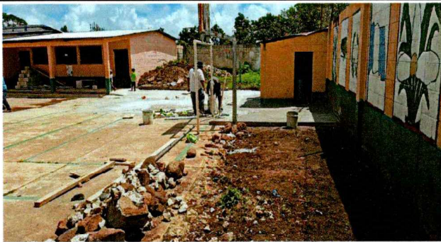
Foto 9: Reparación de losa de patio
