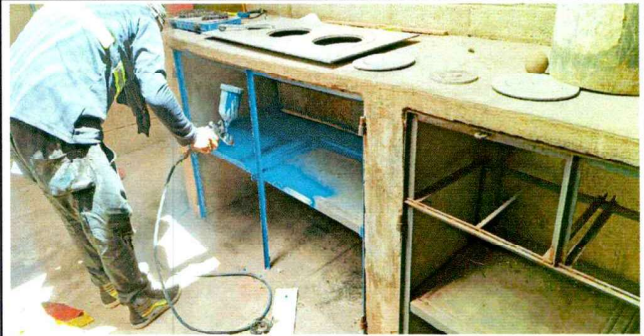
Foto 10 : Mantenimiento y reparación área de cocina.
