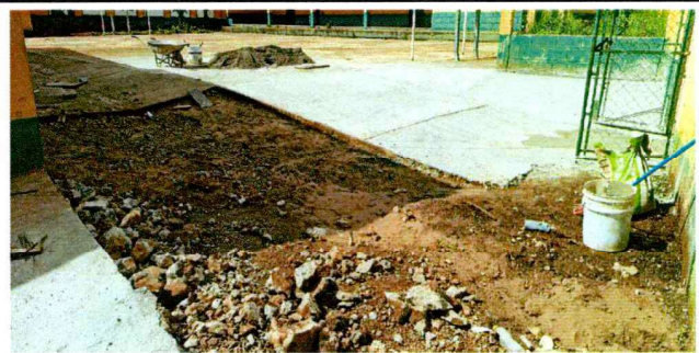
Foto: 6 Sustitución losa de patio ingreso principal.
