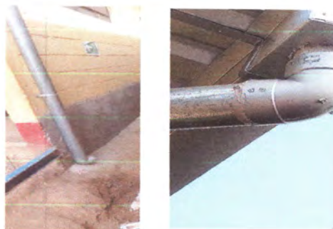
FOTO 2: INSTALACION DE CANALES CON BAJADAS DE AGUA PLUVIAL
