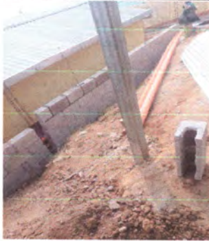
Foto1: LEVANTADO DE MURO
