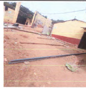
Foto: 6 LOSA DE PATIO EN DIFERENTES AREAS
