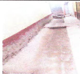
Foto: 6 LOSA DE PATIO EN DIFERENTES ÁREAS
