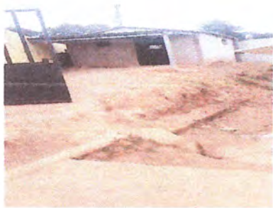
Foto1: LEVANTADO DE MURO
