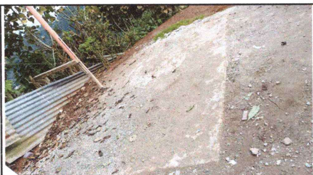
Foto 3: Reparación Losa de Patio
